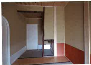
壁の剥落防止と、衣服と壁の両方を保護するために、腰の部分に美濃紙などの和紙を貼ること
